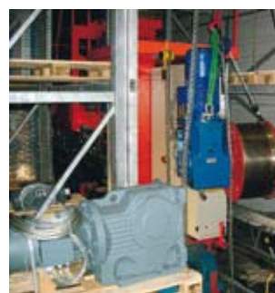
→ Motor de elevación antiguo y nuevo
